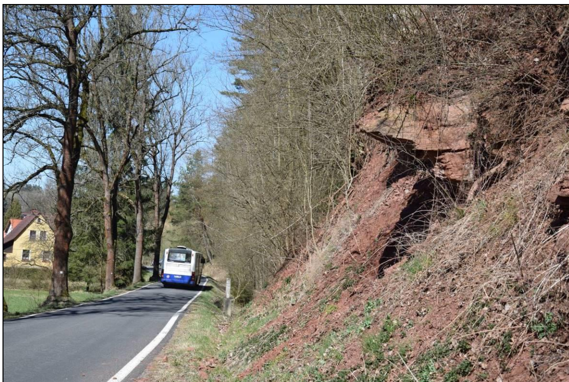
Foto 7 Nestabilní převíslý blok (detail viz foto 4), pohled od jihu, severní část nestabilního úseku vyznačeného na obrázku 4.
