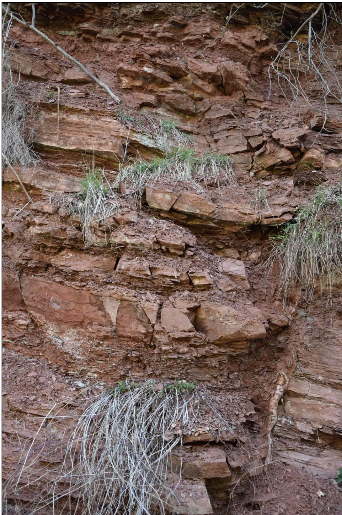
Foto 14 Výrazně rozvolněné dílčí části svahu hrozící pádem dílčích úlomků, střední část nestabilního úseku vyznačeného na obrázku 4.
