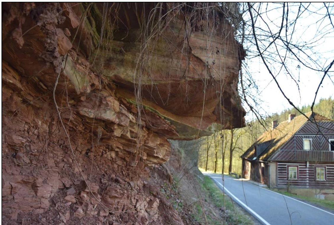
Foto 8 Nestabilní převíslý blok (detail viz foto 4), pohled od severu, severní část nestabilního úseku vyznačeného na obrázku 4. Vpravo dům čp. 207.
