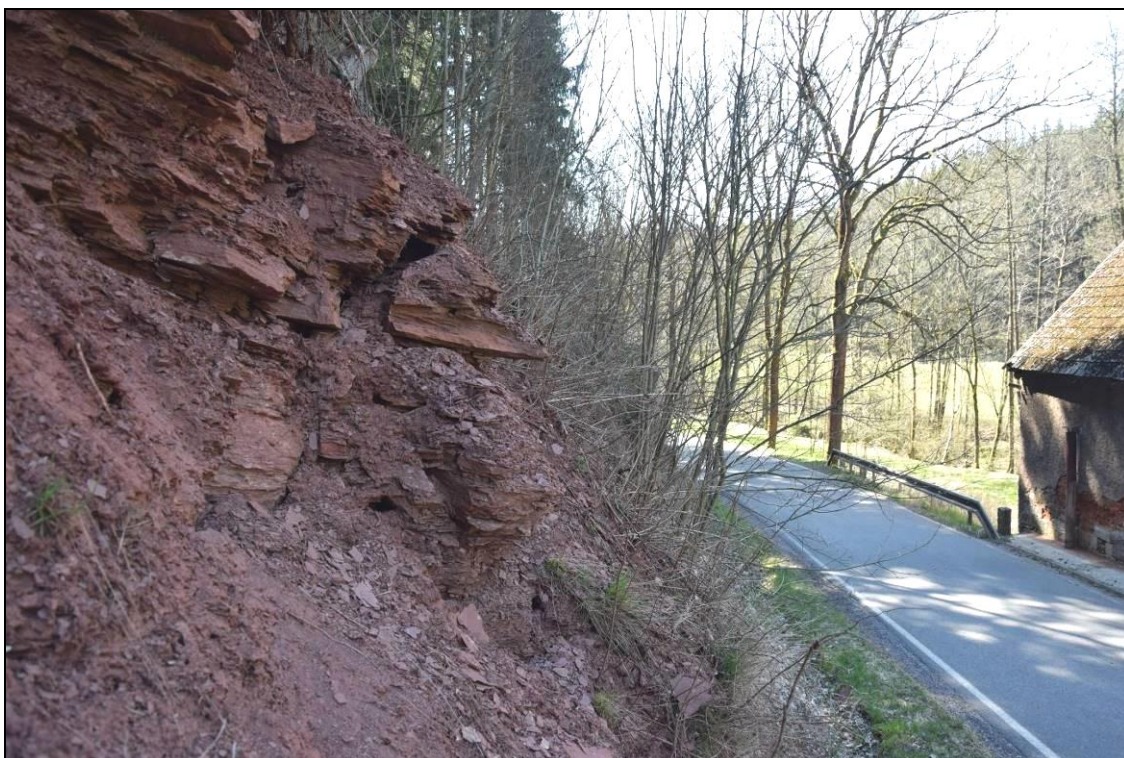
Foto 12 Velmi rozvolněné dílčí části svahu s výrazně uvolněným dílčím blokem, střední (až jižní) část nestabilního úseku vyznačeného na obrázku 4. Vpravo dům čp. 207.
